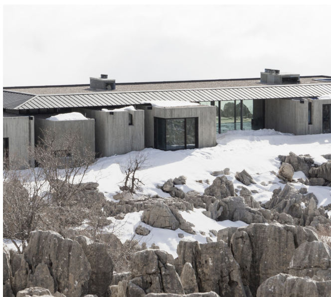
Cobertura com Junta agrafada VMZINC® - ANTHRA-ZINC® - Arquiteto: Karim Nader Studio - Faqra - Líbano
