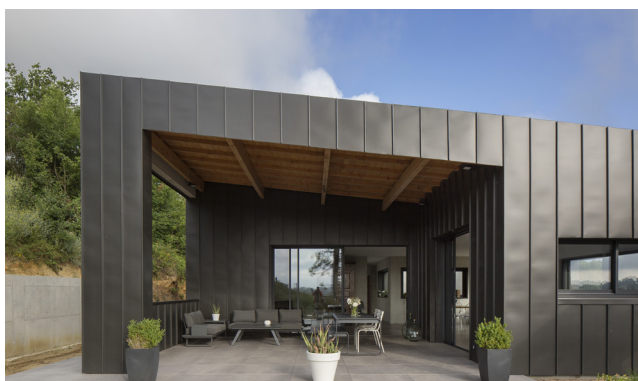
Cobertura com Junta agrafada VMZINC® - PIGMENTO® a pedido - Arquiteta: Amélie Couffignal - Onet-le-Château - França
