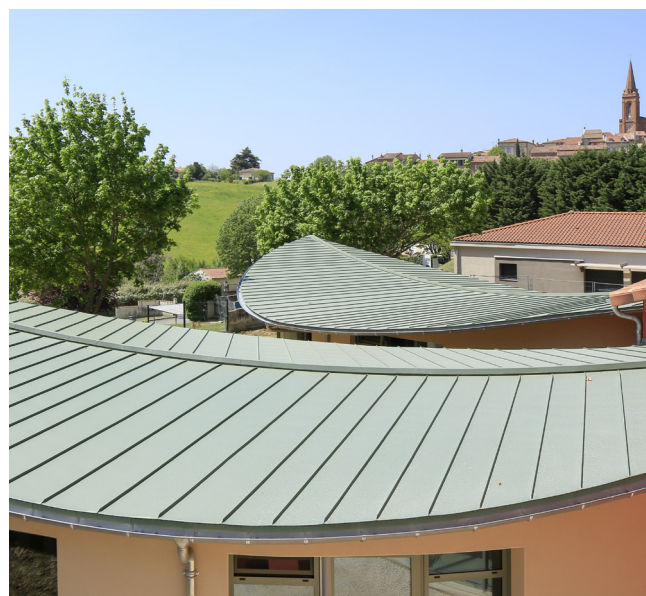
Cobertura com Junta agrafada VMZINC® - PIGMENTO® verde líquen - Arquiteto: Bamboo - Caraman - França
